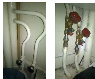
A gauche : vannes d'isolement anciennes A droites, vannes TA
